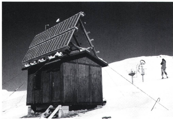
Figur 1 Photovoltaikanlage mit einer Spitzenleistung von 1,2 kW
