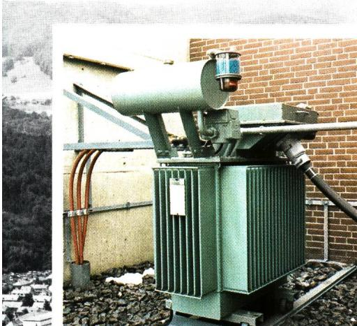
Das ist Verteiltrafo-Standard. Weltweit zehntausendfach bewährte Öltrasfos in verschiedenen Ausführungs- und Anschlussvarianten. Leistungsbereich 50 bis 2500 kVA:
