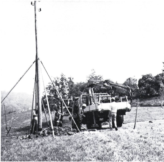
Figur 4 Der Mast steht im Loch und wird mit 4 «Stickern» abgestützt und ins Lot gebracht.
