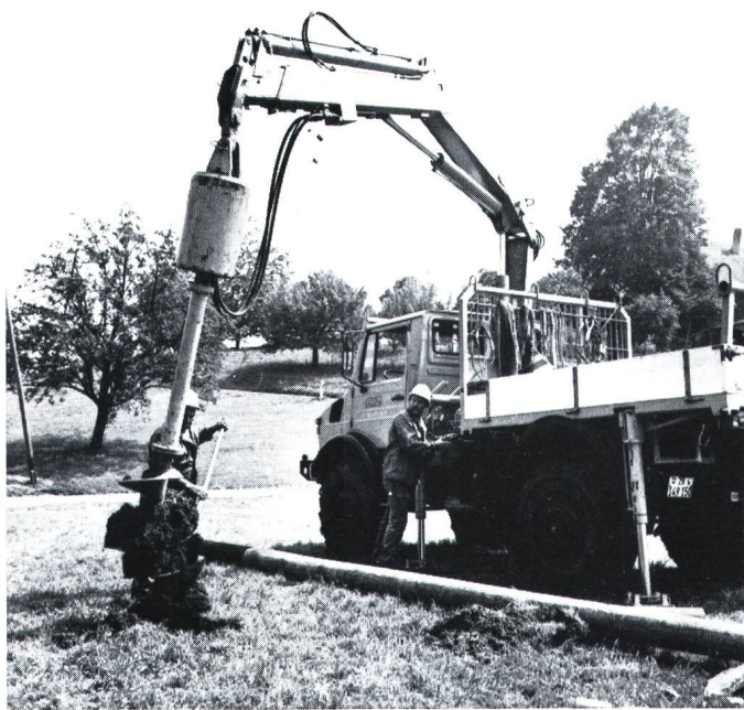
Figur 1 (oben links) und 2 (unten links) Bohrgerät beim sogenannten Ausheben des Mastloches. Das Fahrzeug Unimog ist mit Abstützvorrichtung an 4 Punkten abgestützt. Für den vorgesehenen 13-m-Holzmast wird ein Loch mit einem Durchmesser von 0,55 m auf eine Tiefe von 1,80 m ausgehoben.
