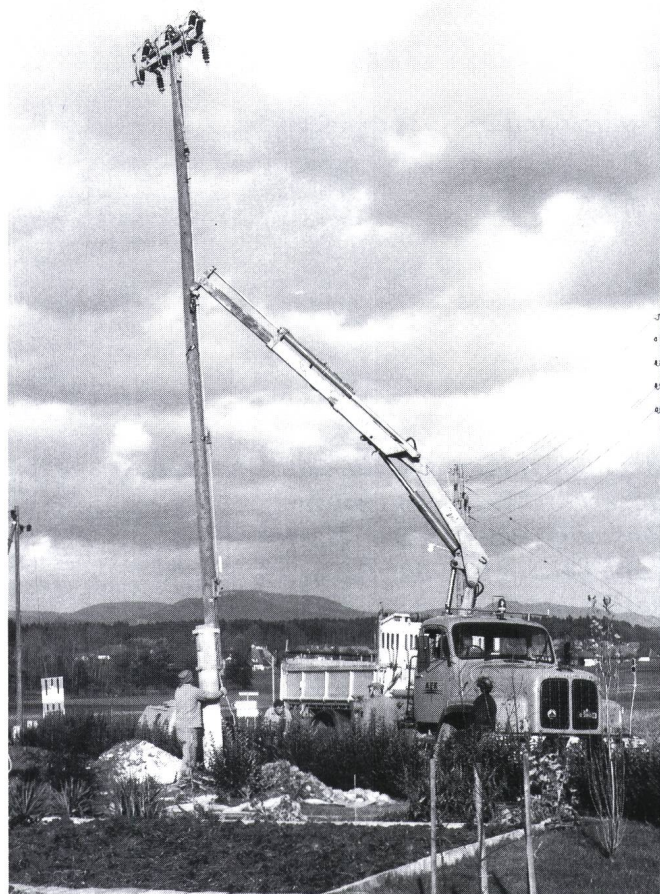
Figur 3 Stellen eines Schaltermastes mittels Lastwagen und Kran. Ohne Kran wären für diese Arbeit 6 Monteure notwendig (Zeitaufwand ohne Transport 1 Std.). Mit Kran bewältigen 3 Mann diese Arbeit in 10 Minuten.
