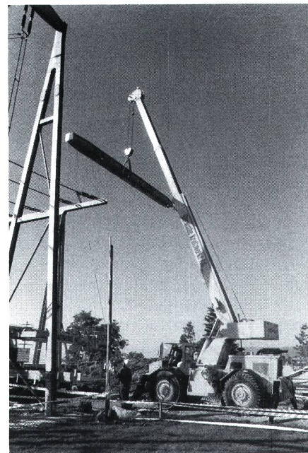
Figur 5 Mobilkran RT 58 beim Anheben eines Querriegels für eine Unterstation
