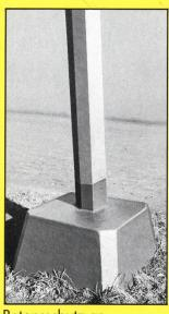
Betonsschutz an Mastsockeln
