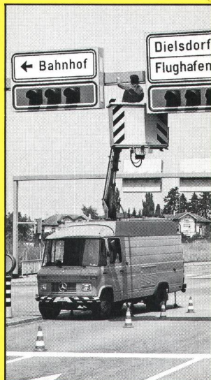
Korrosionsschutz an Signalanlagen
