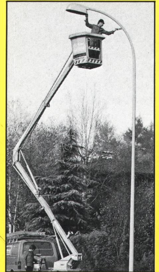
Korrosionsschutz an Stahlkandelabern
