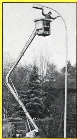
Korrosionsschutz an Stahlkandelabern
