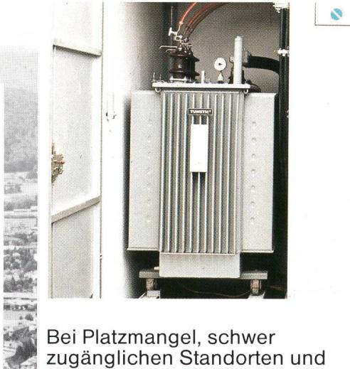
Bei Platzmangel, schwer zugänglichen Standorten und erhöhten Anforderungen an die Wartungsfreiheit ersetzt ein hermetisch geschlossener, elastischer Faltwellenkessel das Expansionsgefäß:
