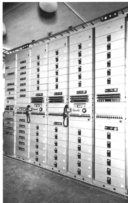
Figur 8 Trägerfrequenzanlage Lausanne, Baujahr 1952 6 Gestelle mit total 48 Kanälen
