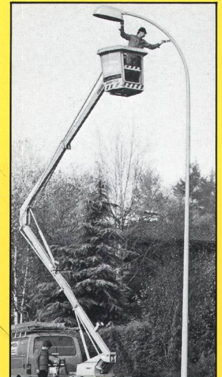
Korrosionsschutz an Stahlkandelabern
