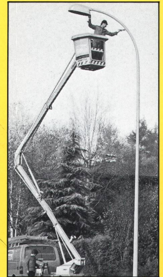
Korrosionsschutz an Stahlkandelabern
