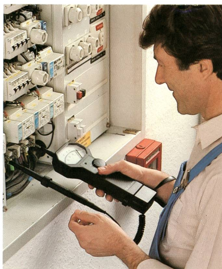
Isolationswiderstandsmessung
