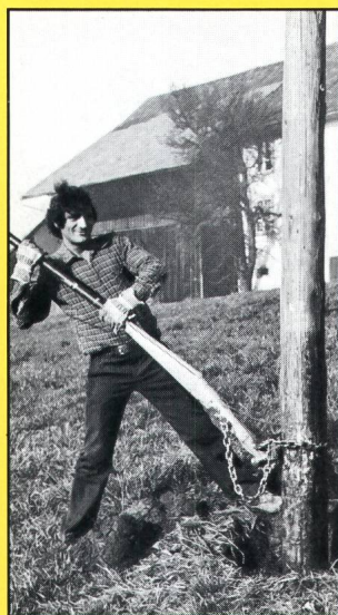
Nachimprägnierung von Holzmasten
