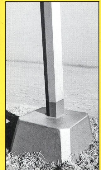
Betonsschutz an Mastsockeln
