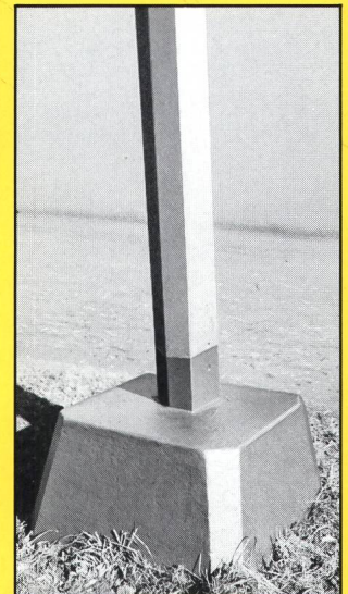
Betonsschutz an Mastsockeln
