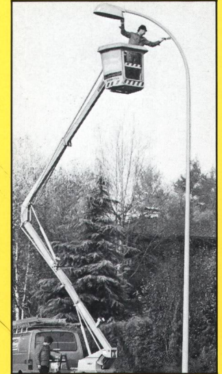
Korrosionsschutz an Stahlkandelabern
