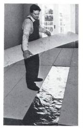
Der JOWITHERM-Elektro-Wärmeboden hat eine Aufbauhöhe von nur 12 mm plus gewähltem Bodenbelag. Die einzelnen Plattenelemente (Grösse 50×200 cm) bestehen aus glasfaserverstärktem Kunststoff und sind SEV-geprüft. Sie werden nur auf dem vorhandenen Boden aufgelegt, angeschraubt und elektrisch kontaktiert.
