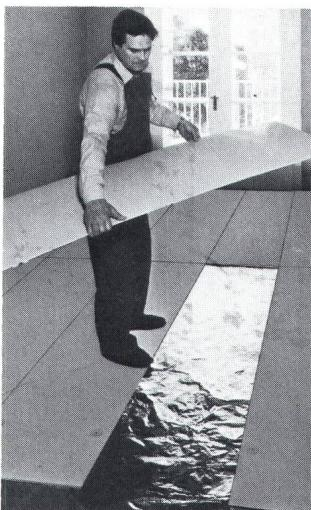
Der JOWITHERM-Elektro-Wärmeboden hat eine Aufbauhöhe von nur 12 mm plus gewähltem Bodenbelag. Die einzelnen Plattenelemente (Grösse 50×200 cm) bestehen aus glasfaserverstärktem Kunststoff und sind SEV-geprüft. Sie werden nur auf dem vorhandenen Boden aufgelegt, angeschraubt und elektrisch kontaktiert.
