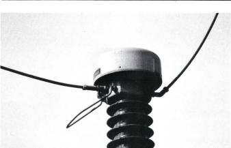
Durch hochempfindliche Teilentladungsmessungen ist sicherzustellen, dass die Wandler im Betrieb teilentladungsfrei sind. Dies kann am besten durch Prüfung nach SEV 3304, 2. überarbeitete Auflage [16], geschehen, indem nach Abschnitt 10.2, Wandler mit flüssiger oder gasförmiger Isola-
