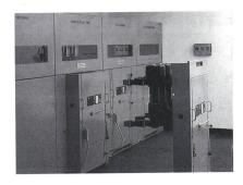
Mittelspannungsanlage Typ PA 106, 24 kV, mit ölarmen Leistungsschaltern, Typ HPTW 506.
