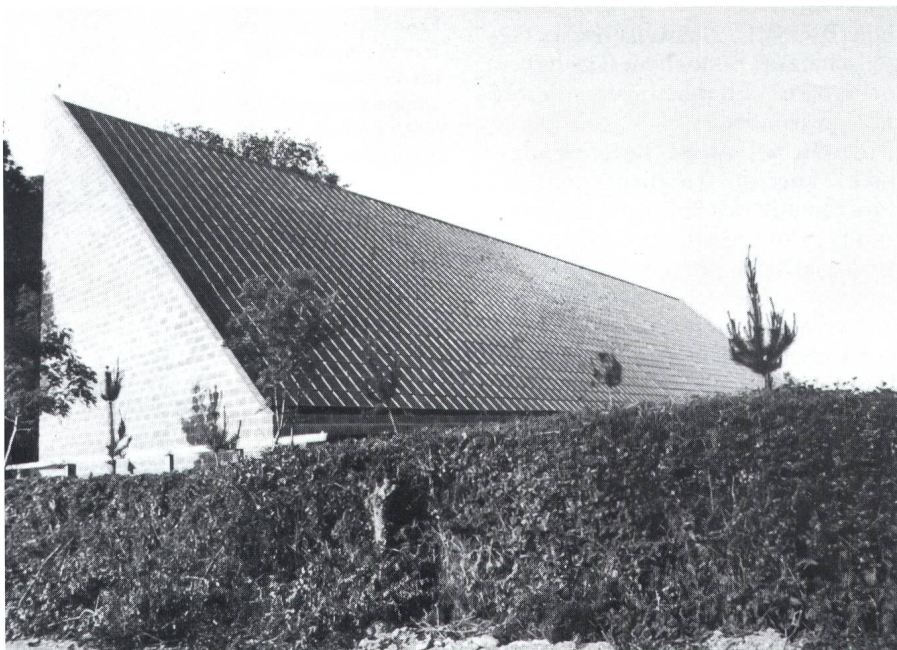
Figur 3 Ein ganzes Hausdach mit photovoltaischen Kollektoren bedeckt: Eine Milchfarm der Universität Cork auf Fota Island (Irland). Die gesamte Dachfläche erreicht eine Nennleistung von 50 kW.
