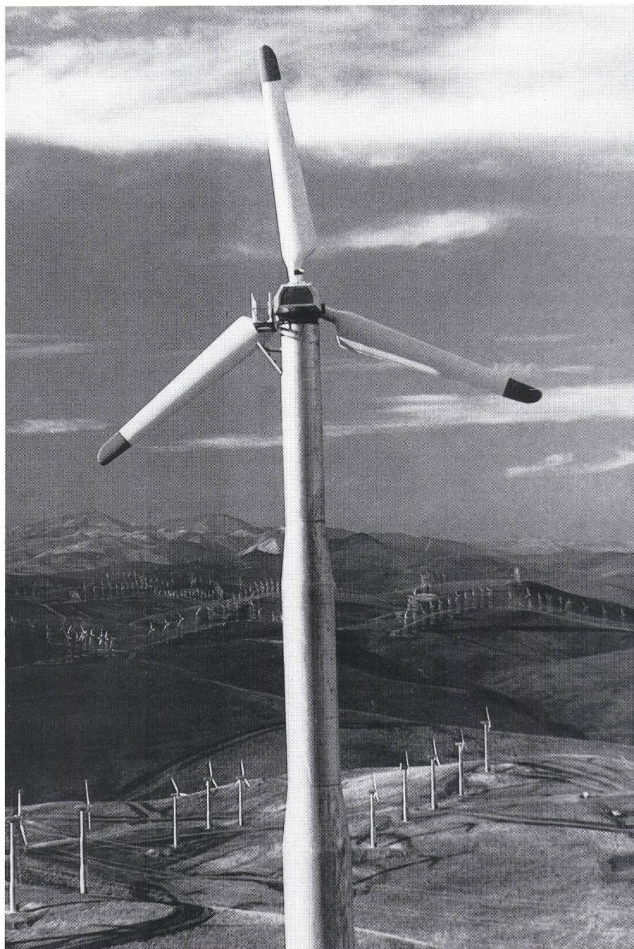
Figure 1 Altamont Energy Corp., windfarm équipée de 250 aérogénérateurs «Nordtank» de 65 kW/unité
