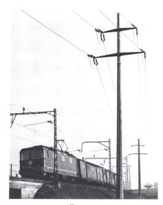
Figur 1 132-kV-Übertragungsleitung für die Bahnstromversorgung: «Kanalisierung» mit bestehender Bahnanlage (Foto SBB/KW)
