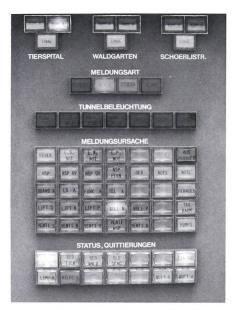
Figur 6 Fernüberwachungstableau in der Leitstelle
