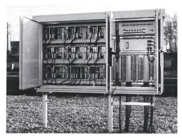
Figur 4 Konzentratorschrank mit acht Steuereinheiten (Kontroller) und einer Speiseeinheit
