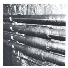
Figur 8 Kabel-Rohrblockanlage mit Muffenstelle im Albulatunnel
