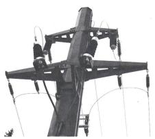
Figur 4 Abspann- und Kabelendmast in Preda
