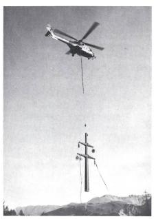
Figur 5 Mastmontage mit Helikopter «Super-Puma»
