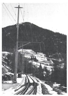
**Figur 6 66-kV-Leitung in Bergün** kombiniert mit der 11-kV-Fahrleitung
