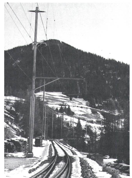
Figur 6 66-kV-Leitung in Berggün kombiniert mit der 11-kV-Fahrleitung
