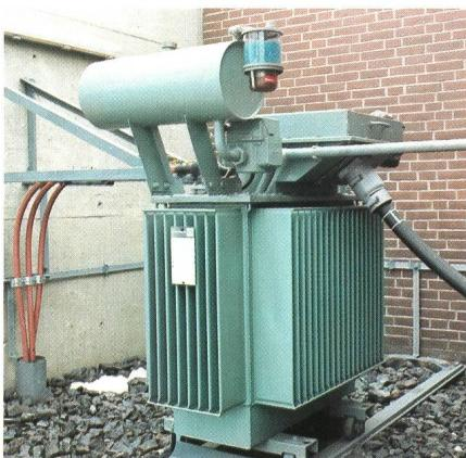
Das ist Verteiltrafo-Standard. Weltweit zehntausendfach bewährte Öltrafos in verschiedenen Ausführungs- und Anschlussvarianten. Leistungsbereich 50 bis 2500 kVA:
