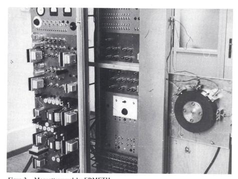
Figur 3. Magnettrommel der ERMETH Versuchsaufbau am Institut für angewandte Mathematik zur Erprobung von Magnetschicht, Magnetköpfen, Schreib- und Leseschaltungen (1952).
