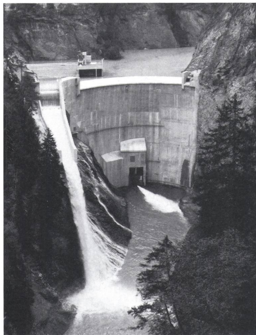
Die Schussrinne der neuen Staumauer Solis in Aktion
