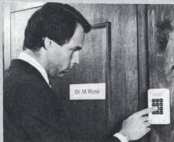
Mit dem Einbau von Safetron werden ungebetene Gäste abgehalten und das Suchen und Mittragen von Schlüsseln entfällt. Neben der Türe ist eine Tastatur. Durch Eintippen eines selbstgewählten Zahlencodes öffnet sich die Türe ohne Schlüssel.
