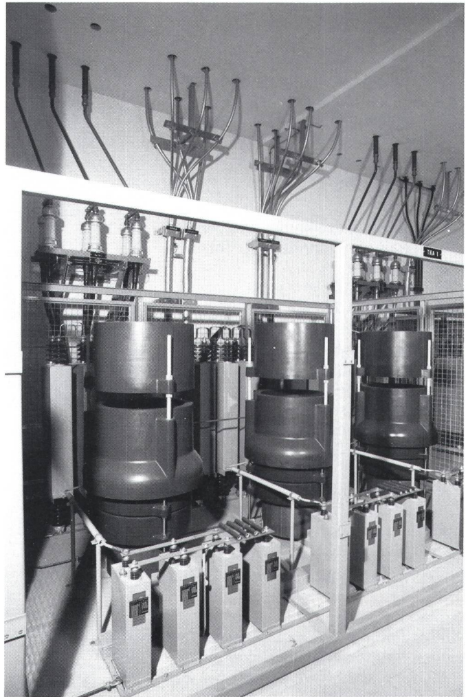
Fig. 6 Parallelankopplung 16 kV, 25 MVA
