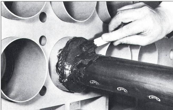
Scotchcast 9580 ist ein spachtelbares, elastisches Polyurethan-Harz: für garantierter gas- und wasserdichte Abdichtungen von Kabelkanälen, Kabel-, Gas- und Wasserrohreinführungen in Gebäude; auch für Dichtungen zwischen Rohr und Mauerwerk.
