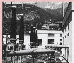
Die «thermische Stabilität» kann somit für sehr hohe Nennströme von bis zu 6000 A, auch in Tropenländern mit Umgebungstemperaturen bis 50 °C und Sonneninstrahlung bis 1000 W/m<sup>2</sup>, garantiert werden. Damit die Durchführungen dem Prüfdruck von 30 bis 45 bar standhalten, verwendet Haefely eine Zwischenkammer aus porenfreiem und reissfestem Isoliermaterial, die das Gasvolumen in der Durchführung in einen Hoch- und
