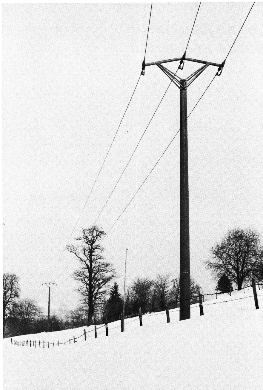
Fig. 1 Efforts d'unification : lignes aériennes MT à longues portées
