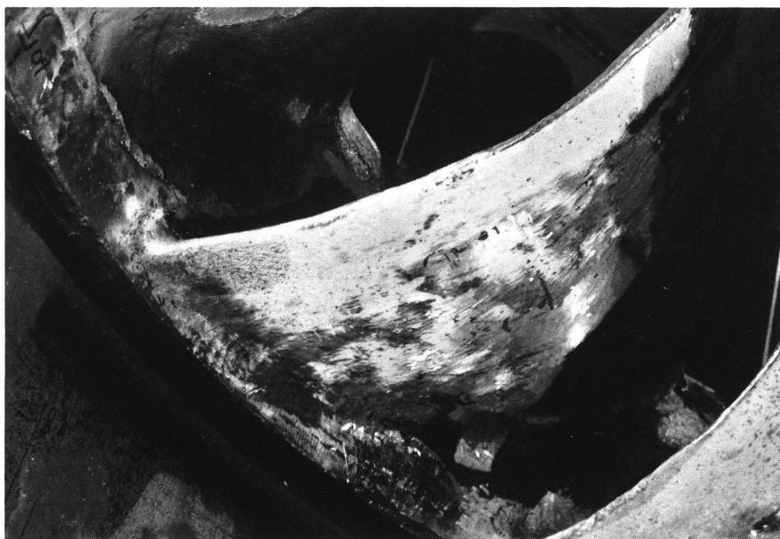
Fig. 3 Beispiel eines inspizierten Turbinlauftrades mit repariertem Schaufelaustritt
