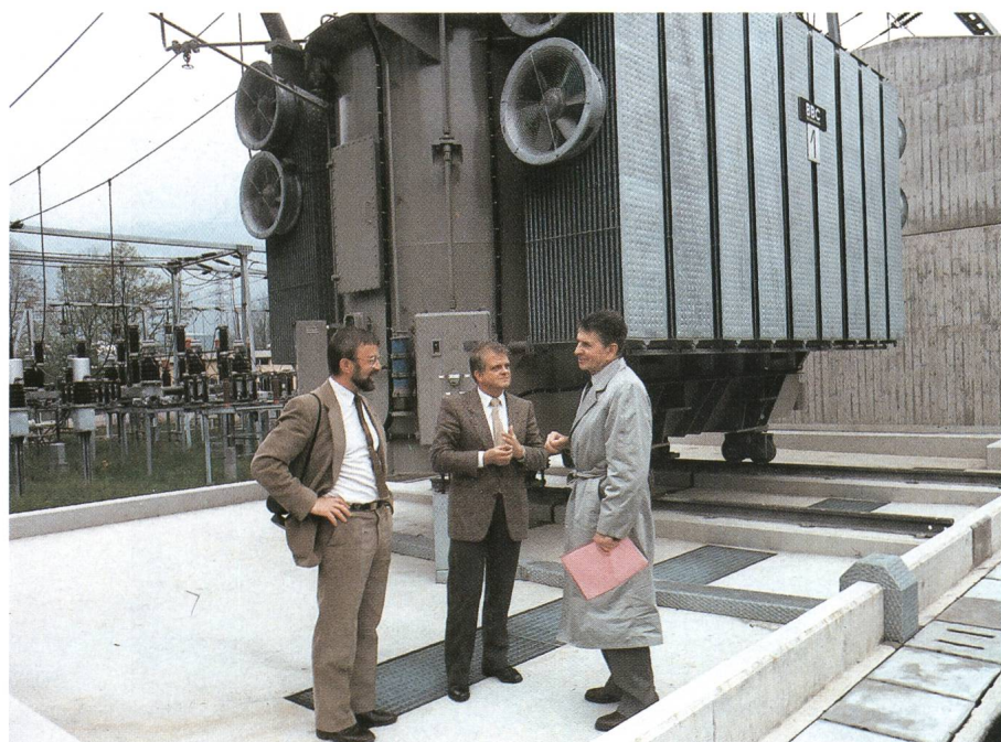
Unterwerk Mendrisio mit 2×100 MVA Transformatorenleistung 150 kV/50 kV anlässlich der Inspektion der Erdungsmessungen durch das Eidg. Starkstrominspektorat
