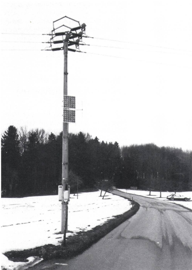
Fig. 3 Photozellen dienen zur Speisung der Batterie des ferngesteuerten Trennschalters einer Freileitung (Photo: EEF)
