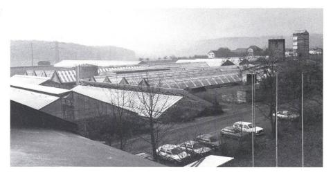
Fig. 4 Mit einem Heizanschluss von vorerst 5000 kW werden 24 grosse Gewächshäuser versorgt. 1000 Tonnen Heizöl pro Jahr werden durch Fernwärme aus dem KKW Beznau ersetzt.
