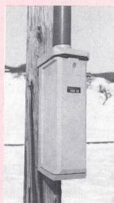
tronen). Die hauptsächlich aus Keramik bestehenden Sicherungsunterteile verbürgen gute Kriechstromeigenschaften. Es stehen alle gebräuchlichen Rohr- und Einführungsteile, -platten und -verschlüsse zur Verfügung.
