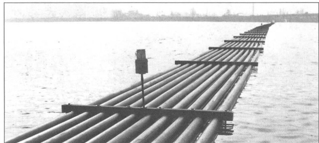
Der Rohrblock mit Briden wird abgesenkt.
