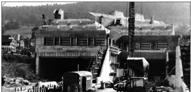
Tunnel-Rohbau Seite Weiningen mit später bepflanztem Lärmschutzwall
