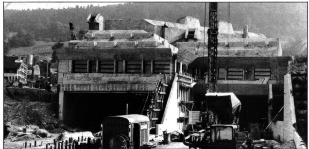
Tunnel-Rohbau Seite Weiningen mit später bepflanztem Lärmschutzwall
