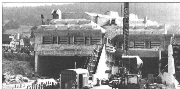
Tunnel-Rohbau Seite Weiningen mit später bepflanzttem Lärmschutzwall
