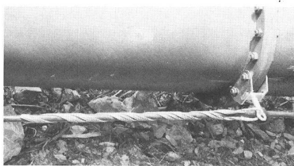
Fig. 4 Endabspannung des Luftkabels
