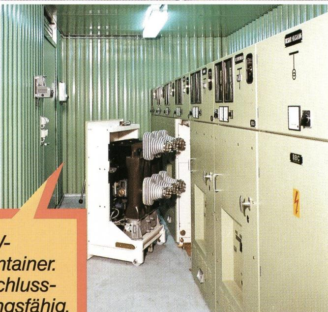
*Die komplette 24-kV-Schaltanlage im Container. Schlüsselfertig, anschlussbereit und anpassungsfähig. Das spart Bauzeit und Gebäudekosten.*
