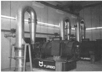
Fig. 2 Turbomaschinen mit je 450 kW Leistung zur Belüftung der Klärbecken
