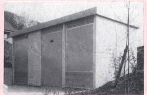
Erweiterung oder ein Materialmagazin. In einer solchen Station können bis  $2 \times 1000$  kVA / 24 kV Leistung auf einer Grundfläche von  $5,5 \times 2,5$  m untergebracht werden. Die Außenseiten bestehen aus den üblichen Wandelementen, die Dachplatte ist aus einem Stück gegossen. Die Türen sind aus lichtfestem Kunststoff und die Lüftungsgitter aus Aluminium.
