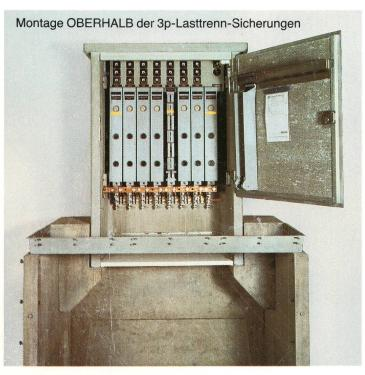
Kabelverteilkabine Gr. I und Fertig-Fundament Gr. II 10 t belastbar mit Reduktion auf Kabine Gr. I
