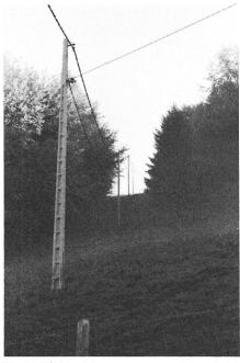
Fig. 3 Câbles aériens sur poteau en béton du réseau BT
