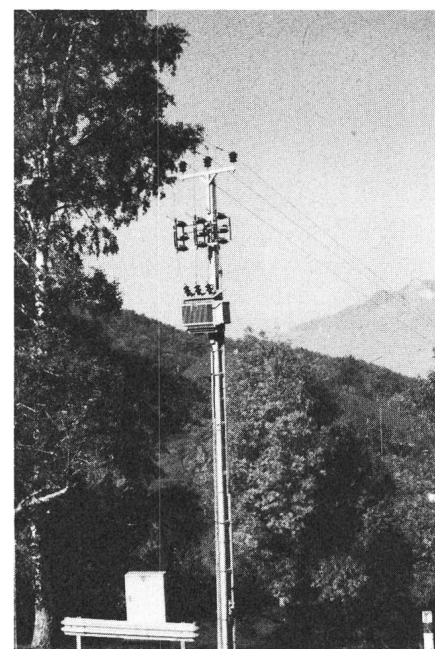
Fig. 5 Poteau en béton, à la fois support de ligne 16 kV et support de transformateur 50 à 160 kVA
