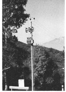
Fig. 5 Poteau en béton, à la fois support de ligne  $16~\mathrm{kV}$  et support de transformateur 50 à  $160~\mathrm{kVA}$
