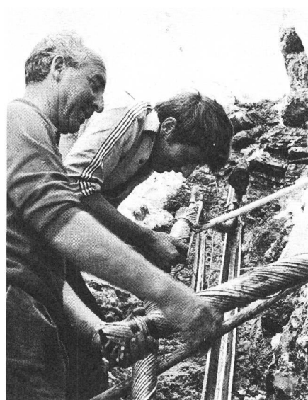
Fig. 3 Jonction de câbles
