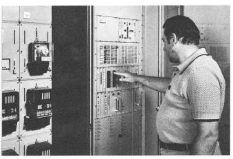
Fig. 5 Steuereinheit der Netzkommandoanlage
