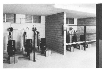
Fig. 4 Ankopplungseinheiten der Rundsteuerungsanlage
