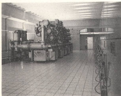
Gekapselte SF 6 -isolierte Hochspannungs-Schaltanlage Sumiswald der BKW; U n = 132 kV, I n = 2000 A, Blitzstossspannung 1/50 µs 550 kV.
