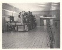
Gekapselte SF<sub>6</sub>-isolierte Hochspannungs-Schaltanlage Sumiswald der BKW;  $U_n = 132 \text{ kV}$ ,  $I_n = 2000 \text{ A}$ , Blitzstossspannung 1/50 µs 550 kV
