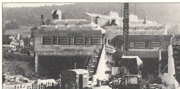
Tunnel-Rohbau Seite Weiningen mit später bepflanztem Lärmschutzwall
