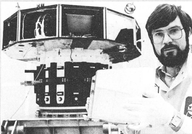
Sensor mit Silizium-Messdetektoren; im Hintergrund halbfertiger Satellit
