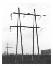
Fig. 3 Betonportalmast 2×380 kV bzw. 380 und 220 kV
