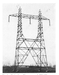
Fig. 2 Bisheriger Gittermast mit 220-kV-Leitung
