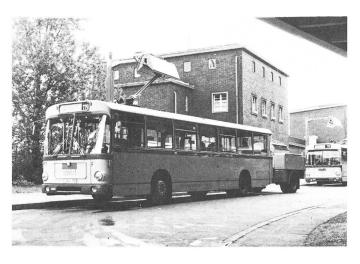
Fig. 3 Batteriebus an Zwischenladeeinrichtung
